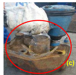
Retirada da tampa
