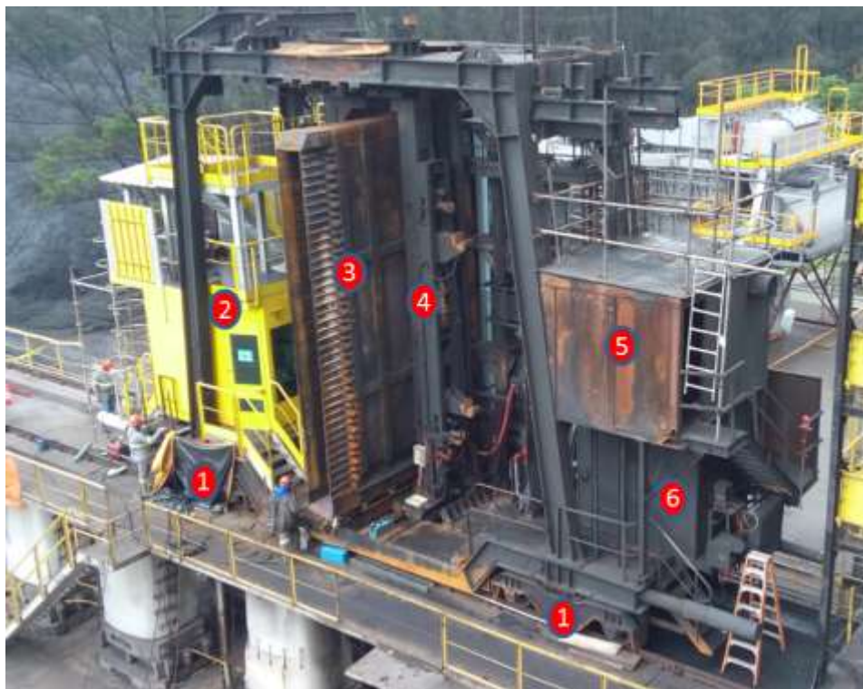
Fotografia 1.5.1 - Guia de Coque Número 2 da Coqueria da ArcelorMittal Tubarão
