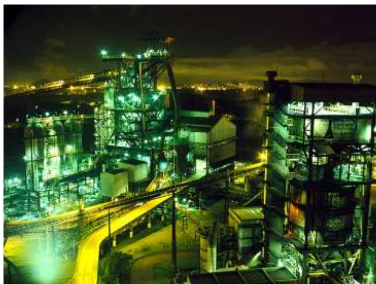
Figura 2.5: Vista dos alto fornos 1 e 2 da CST.
