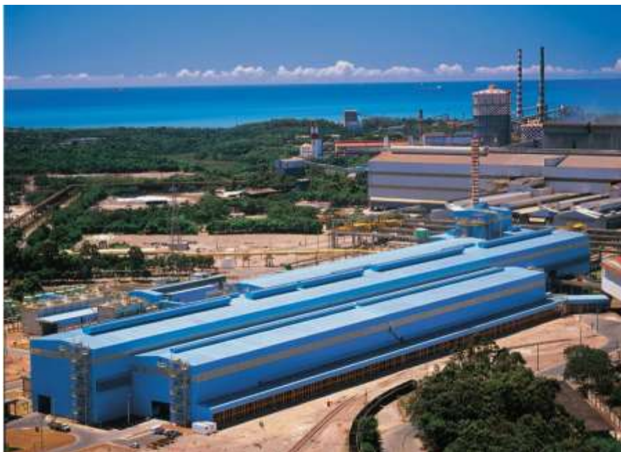
Figura 2.12: Vista externa do galpão de produção de bobinas a quente
