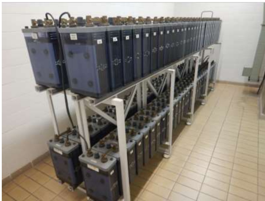
Figura 2: Instalação de sistema de bateria chumbo-ácida estacionária
