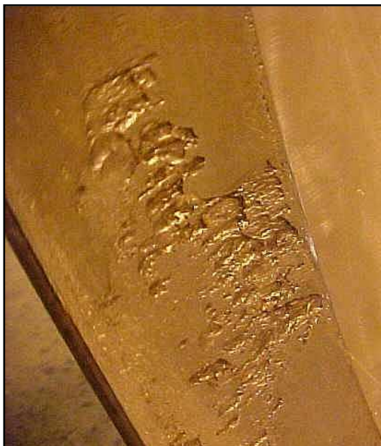
Foto 6 – Destacamento de material na pista Fonte: Autoria própria.
