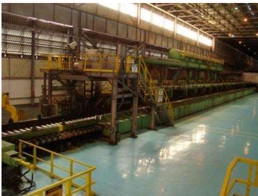
Figura 2.13 – Vista geral de um sistema de resfriamento de bobinas
