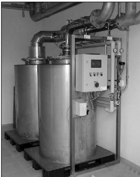
Figura 21 – Filtro de carvão ativado SILOXA modelo GRW 200.
