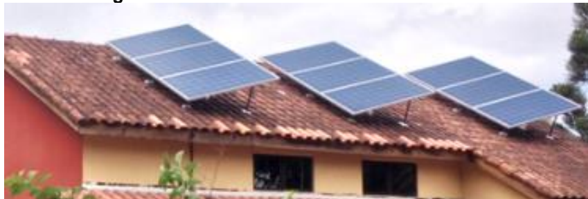
Figura 37 - Vista dos módulos no residencial 8
