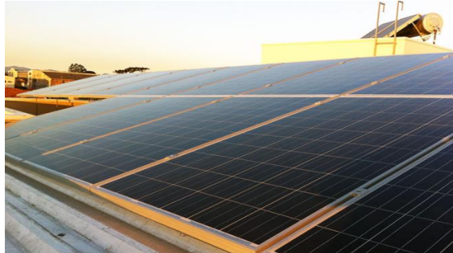
Figura 33 - Vista dos módulos no residencial 6
