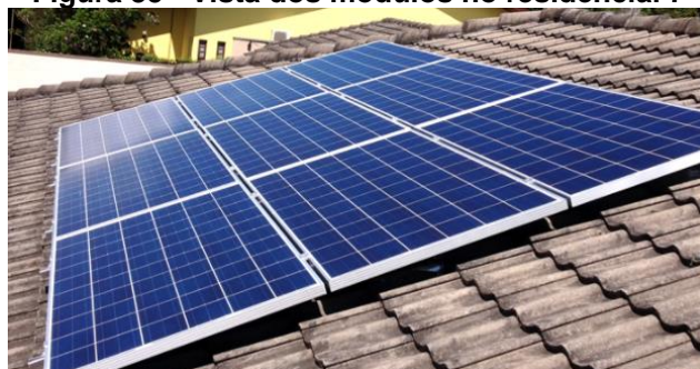
Figura 35 - Vista dos módulos no residencial 7
