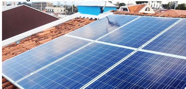
Figura 47 - Vista dos módulos no residencial 13
