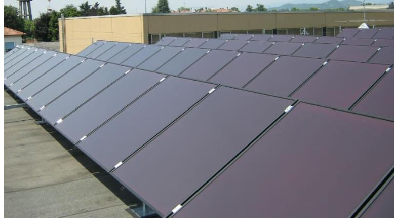
Figura 11 - Módulos fotovoltaicos de filmes finos.
