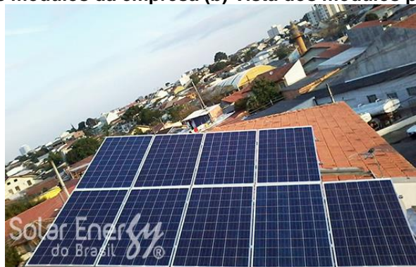
Figura 21 - (a) Vista dos módulos da empresa (b) Vista dos módulos pela entrada da empresa.
