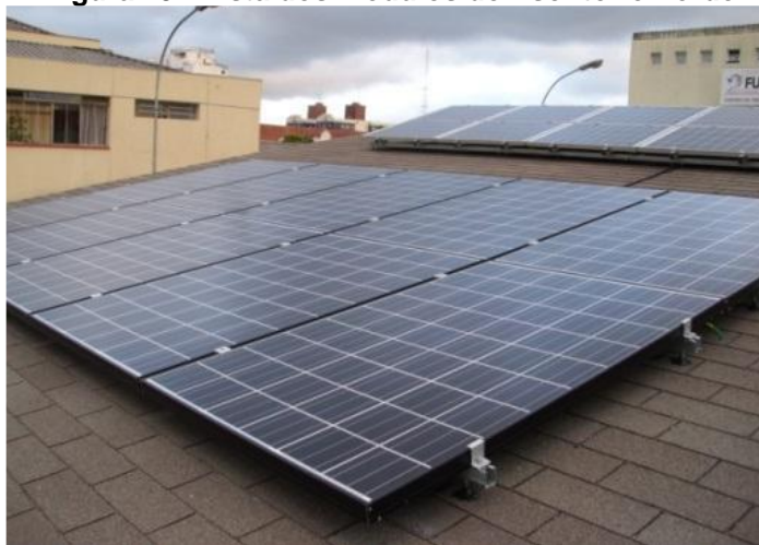
Figura 15 - Vista dos módulos do Escritório Verde
