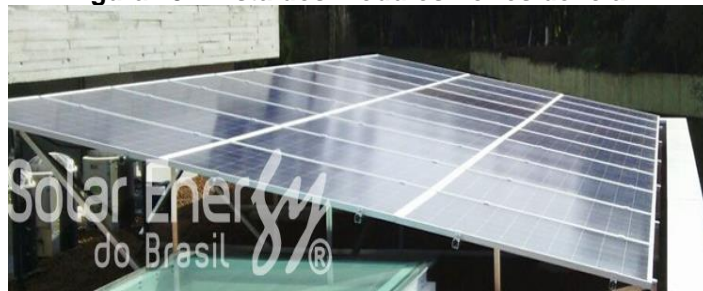
Figura 29 - Vista dos módulos no residencial 4
