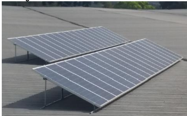
Figura 18 - Vista dos módulos da Neville
