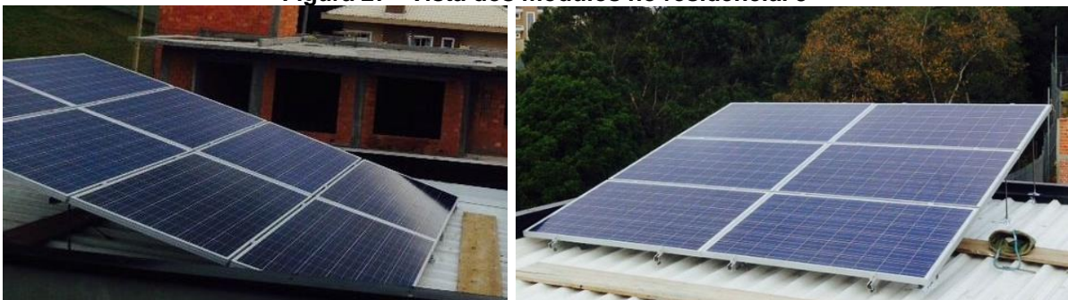
Figura 27 - Vista dos módulos no residencial 3
