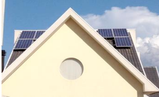
Figura 45 - Vista dos módulos no residencial 12
