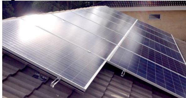
Figura 31 - Vista dos módulos no residencial 5
