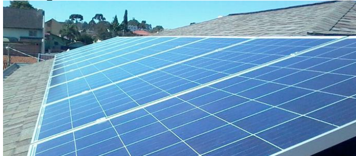
Figura 39 - Vista dos módulos no residencial 9
