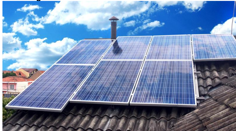
Figura 43 - Vista dos módulos no residencial 11
