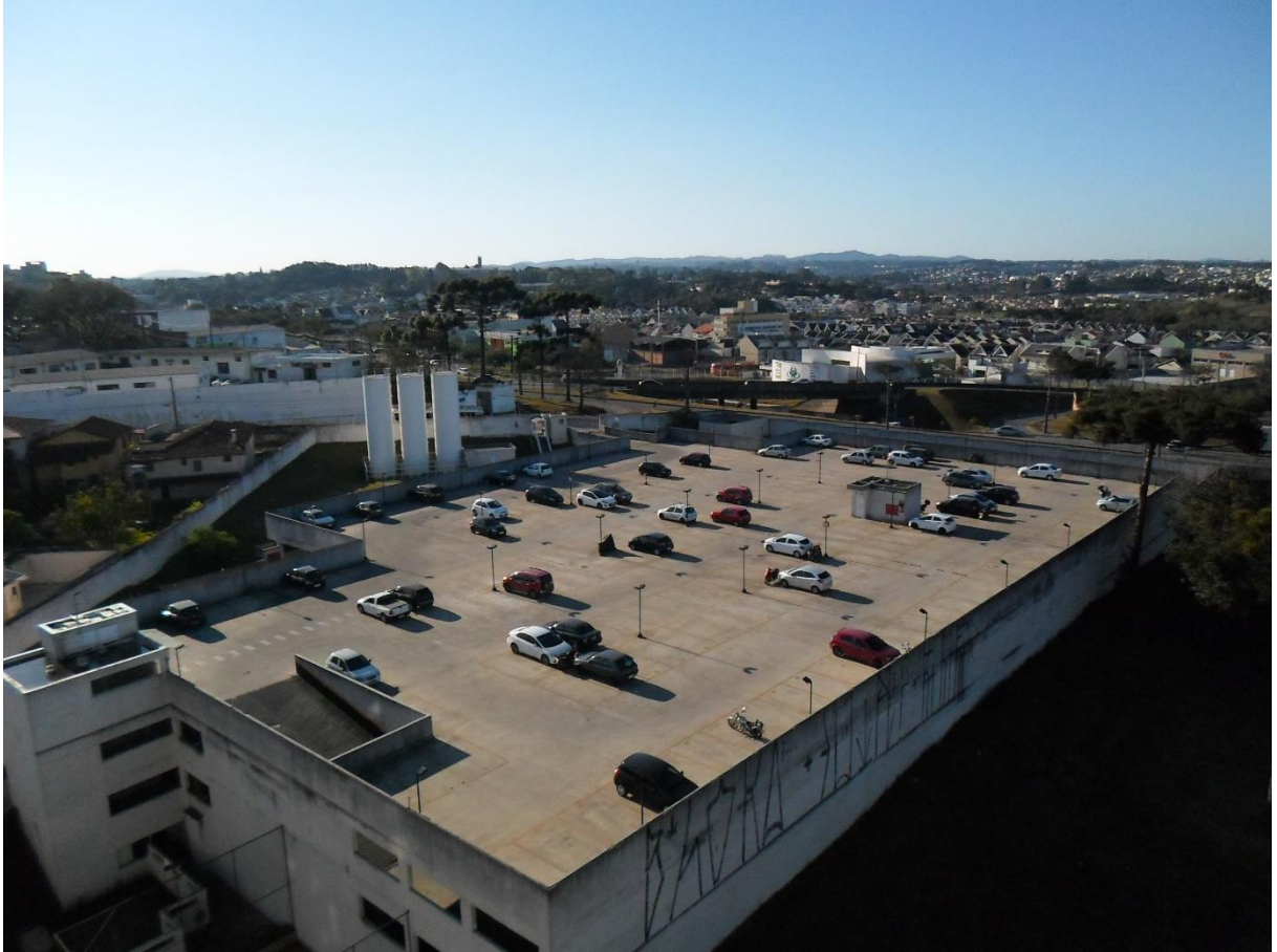
Figura 18 – Visão panorâmica do edifício garagem.
