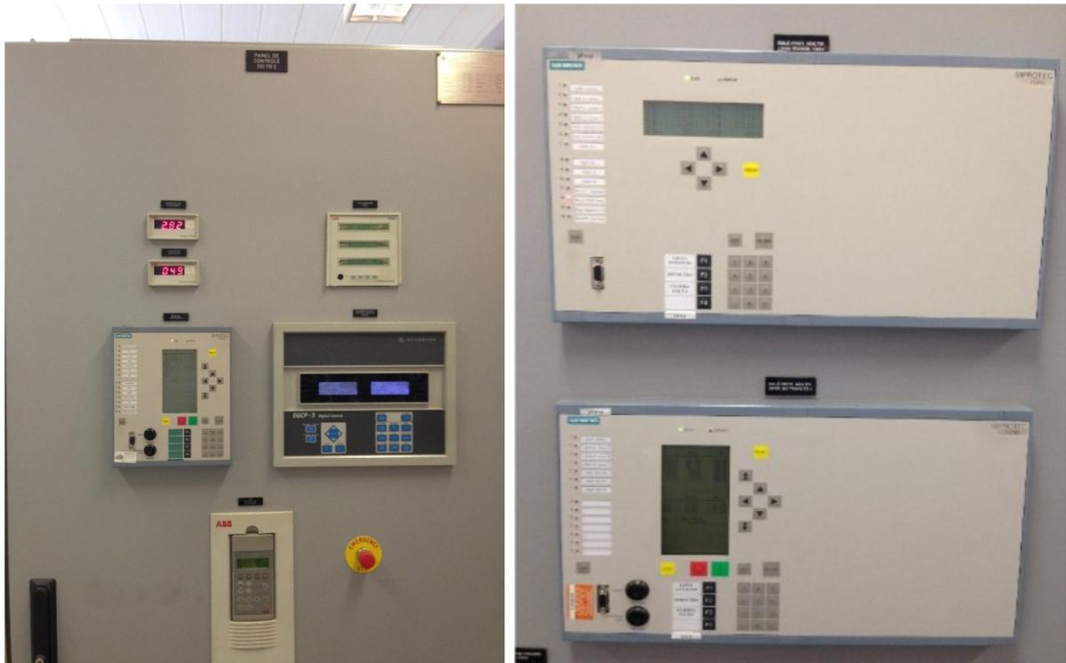
*Figura 19 - Painel de controle do turbogerador e relés de proteção
