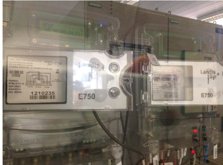
*Figura 18 - Medidores de Energia bidirecionais
