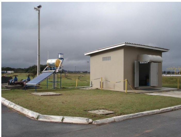
Figura 13 – Fotografia da vista geral do sistema piloto Fonte: Autoria própria.
