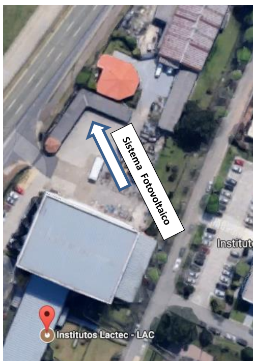
Figura 6 - Localização do sistema fotovoltaico.
