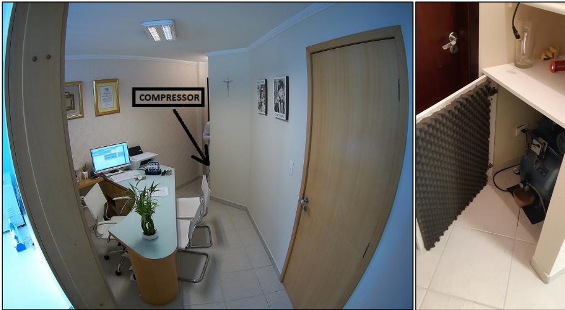
Figura 20. Localização do Compressor. Fonte: Fotografada pelo Autor.
