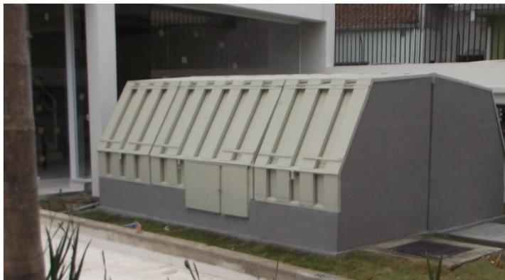
**Figura 4 – Cabine Pré-Fabricada Mista (Semienterrada).**
