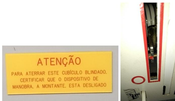
**Figura 33– Sinalização e dispositivo de bloqueio da chave de aterramento.**
