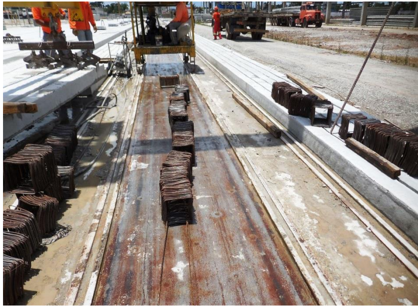
Figura 6 - Lançamento da Armadura Longitudinal Fonte: Autor
