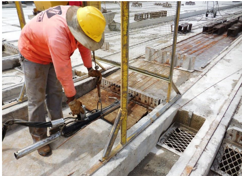
Figura 7 - Protensão de Cabos (Armadura Longitudinal) Fonte: Autor
