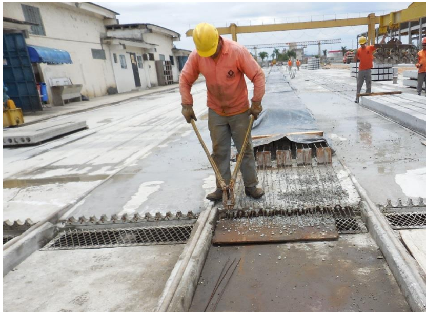
Figura 12 - Desprotenção (Corte da armadura longitudinal) Fonte: Autor
