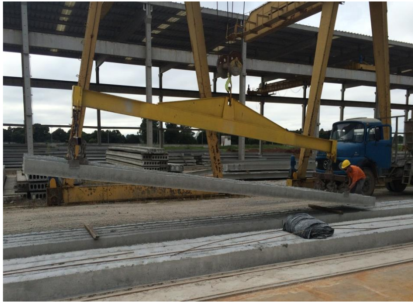
Figura 14 - Retirada das Estacas da Pista Fonte: Autor
