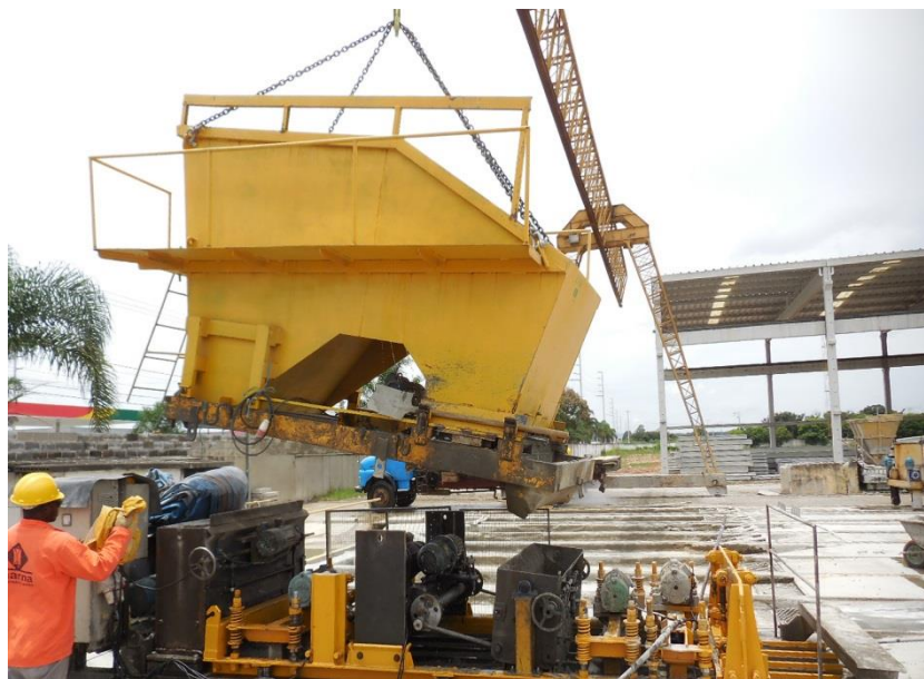
Figura 9 - Posicionamento da Máquina Moldadora na Pista Fonte: Autor
