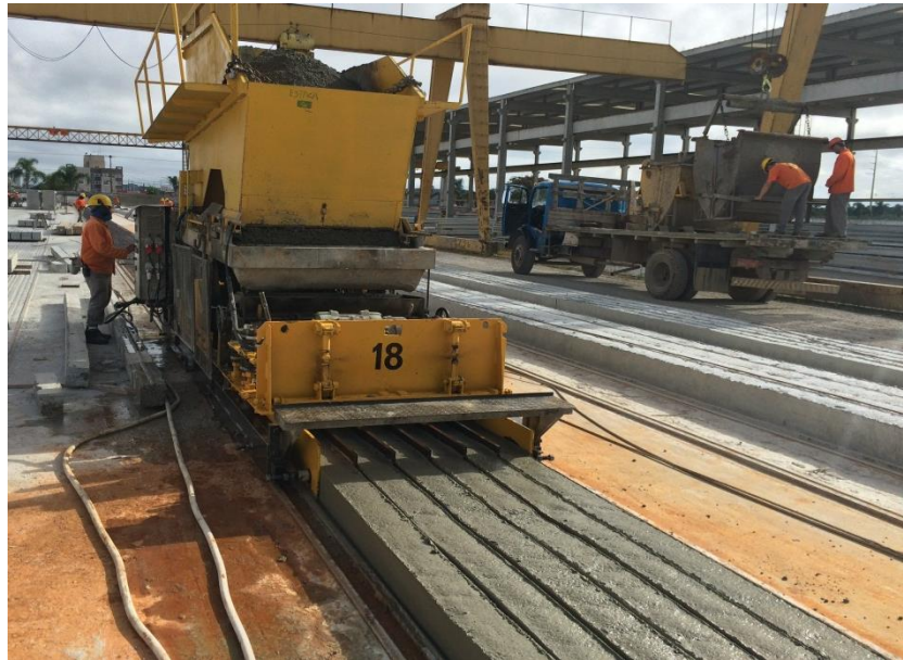
Figura 10 - Concretagem da pista Fonte: Autor
