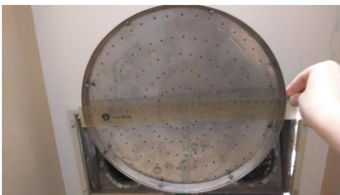
**Figura 14 - Diâmetro do chuveiro de emergência
