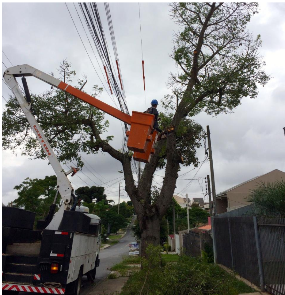
Figura 6: Poda sendo executada na região central de Curitiba - PR
