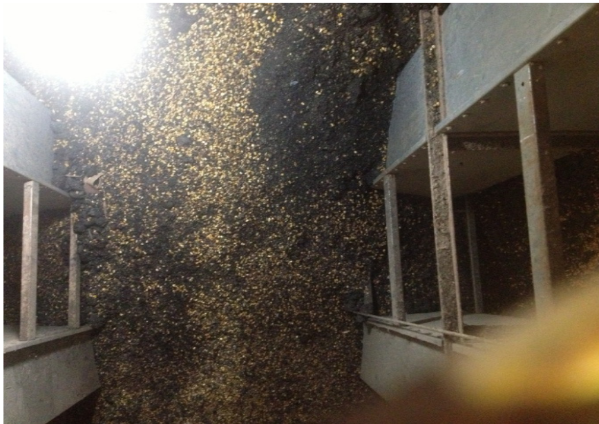
Figura 8 – Material após incêndio Fonte: Autor
