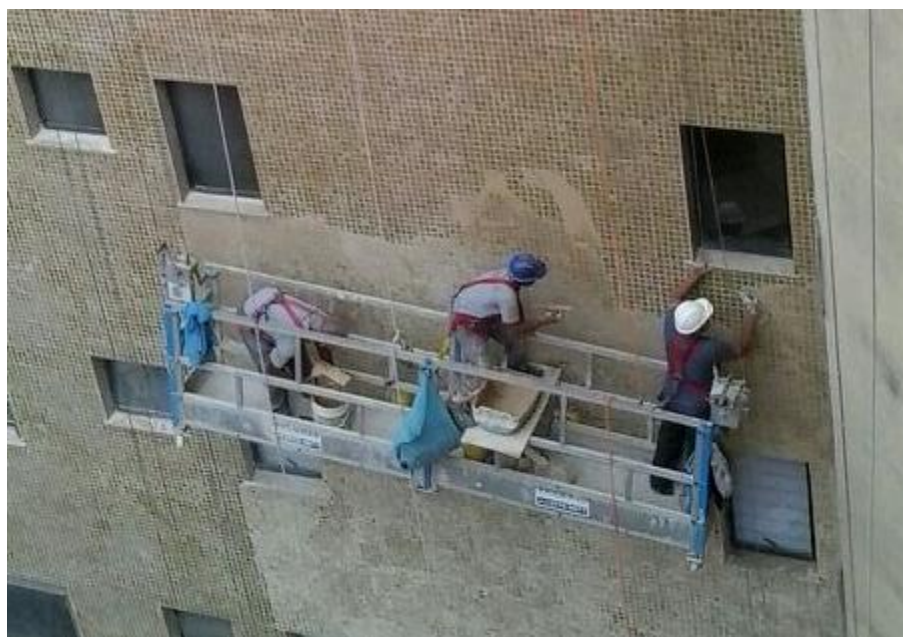
Figura 48. Talabarte e dispositivo trava-queda abaixo da linha da cintura. Fonte: O autor (2014).
