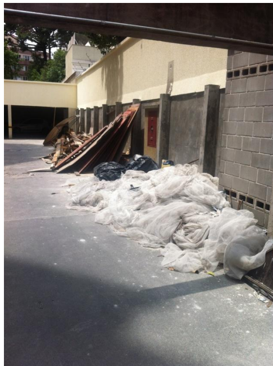
Figura 45. Estocagem de madeiras e tela de proteção utilizadas. Fonte: O autor (2014).
