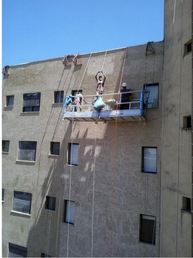
Figura 37. Acesso aos andaimes pelo cabo de segurança. Fonte: O autor (2014).
