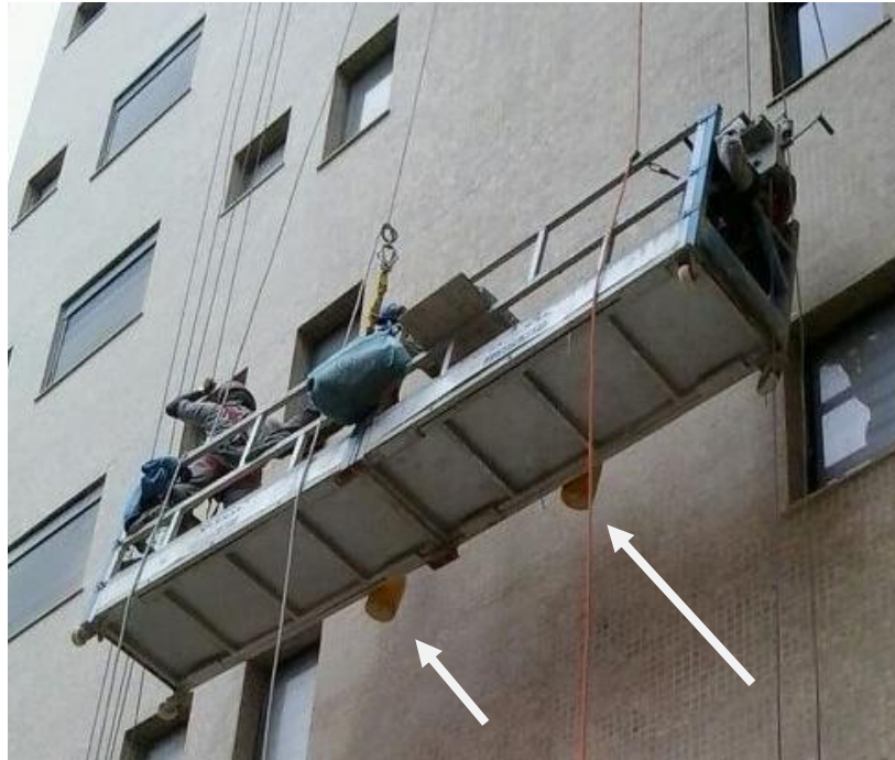
Figura 43. Afastador de parede na cor amarela utilizado e sacos plásticos como contrapeso.
