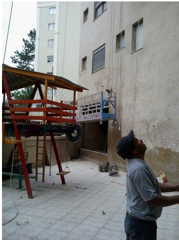
Figura 36. Acesso aos andaimes pela área recreativa do condomínio. Fonte: O autor (2014).
