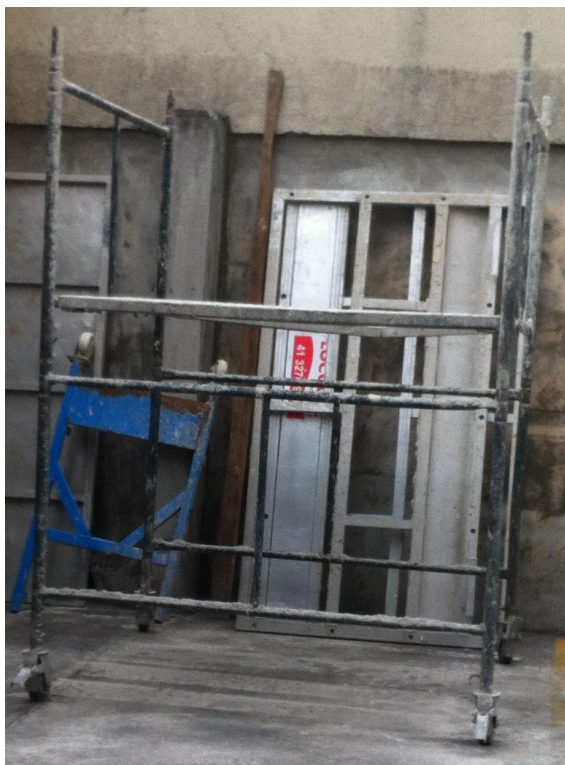
Figura 38. Andaime móvel utilizado na reforma. Fonte: O autor (adaptada) (2014).
