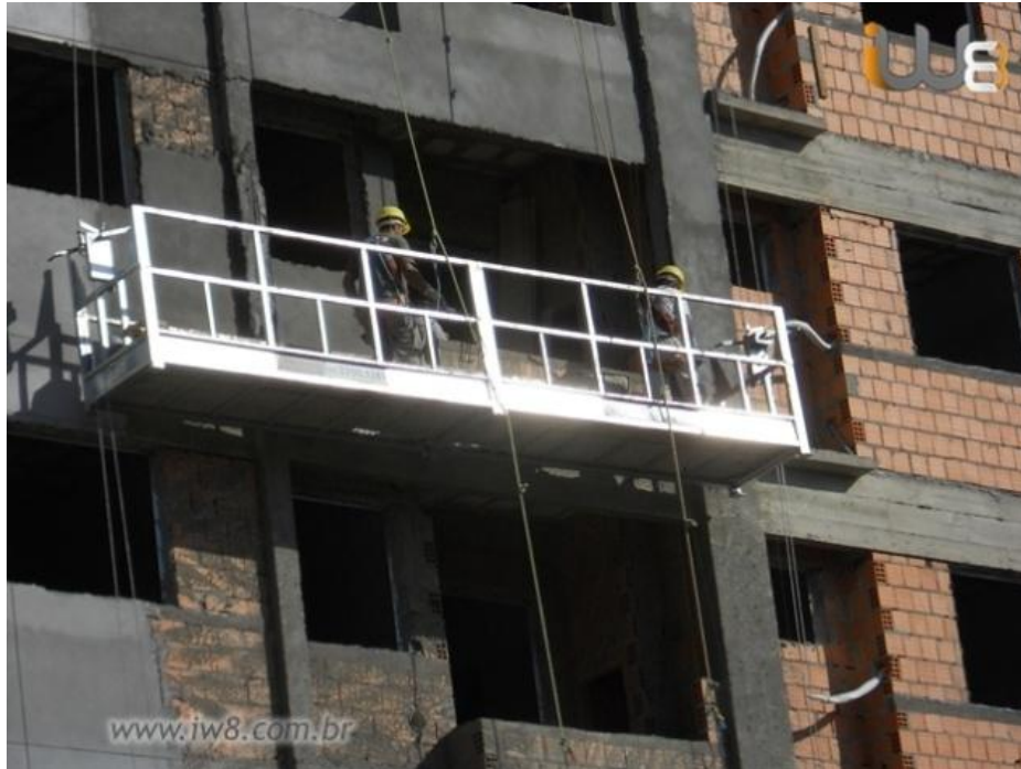
Figura 19. Andaime suspenso. Fonte: Fonte: IW8 EQUIPAMENTOS (2013).
