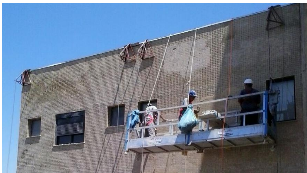
Figura 40. Sistema de sustentação através de afastadores metálicos. Fonte: O autor (2014).
