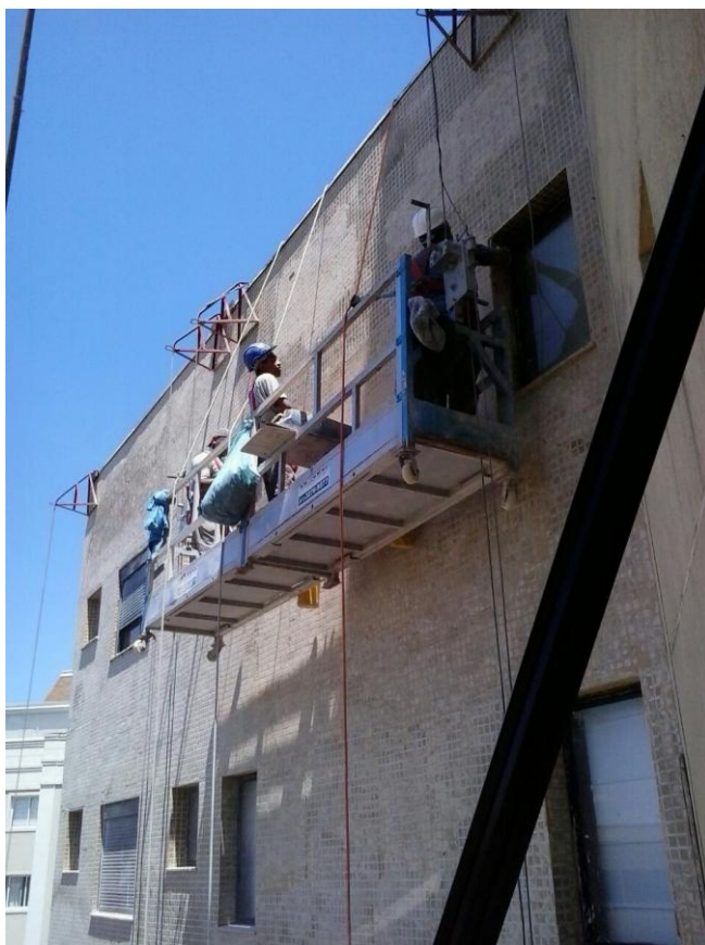
Figura 35. Andaime suspenso com identificação da empresa locadora no rodapé Fonte: O autor (2014).
