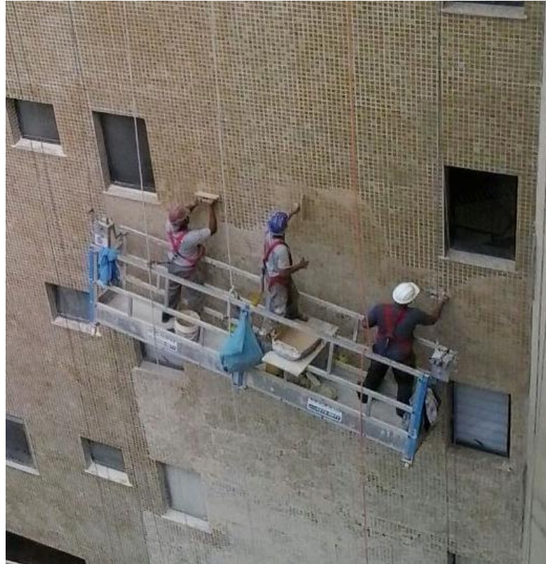
Figura 41. Estrado inclinado na posição de trabalho. Fonte: O autor (2014).
