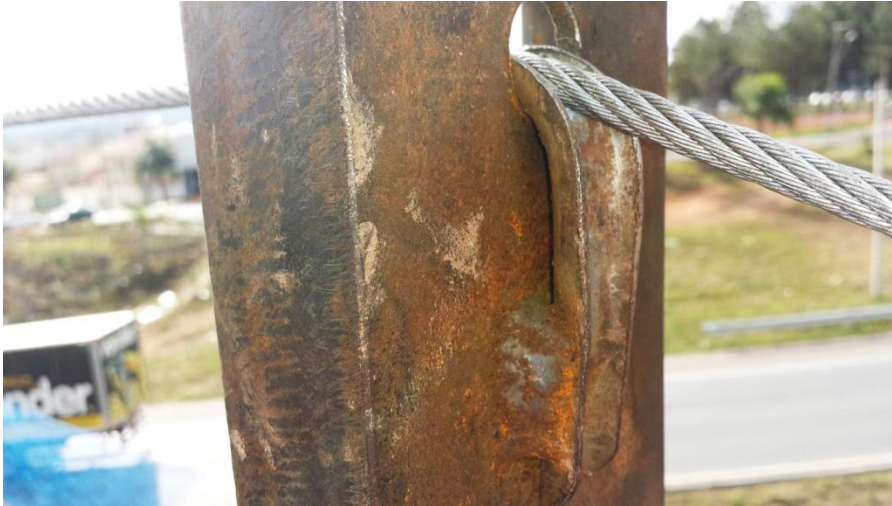
Figura 4 – Sapatilha para proteção de cabo de aço Fonte: O autor (2014)
