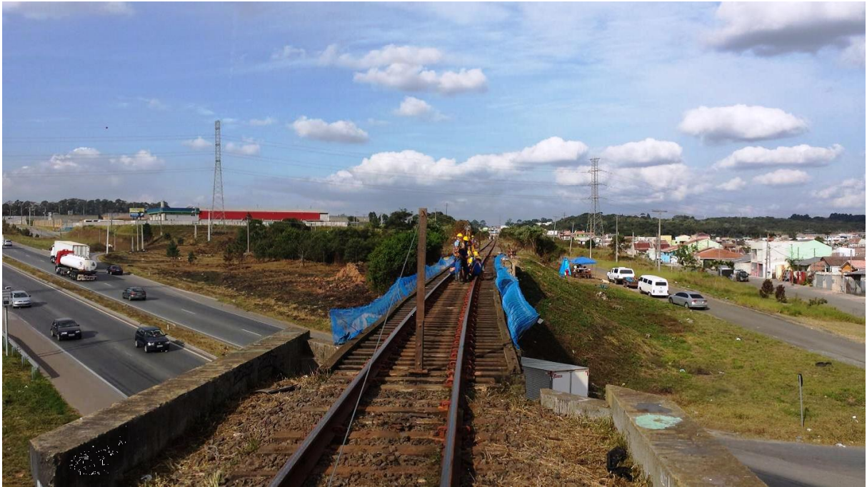
Figura 10 – Visão geral da linha de vida sobre ponte férrea Fonte: O autor (2014)
