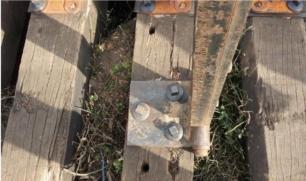
Figura 6 – Viga de sustentação do cabo de aço instalada Fonte: O autor (2014)
