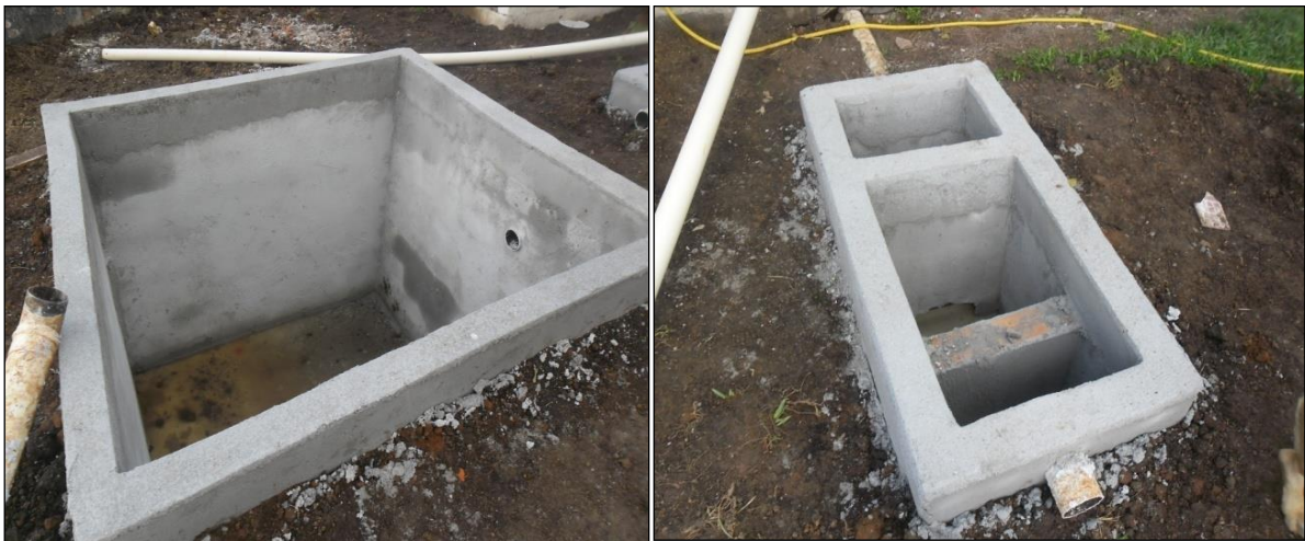
Figura 24A. Construção ETEZR cozinha. Fonte: Autora.
