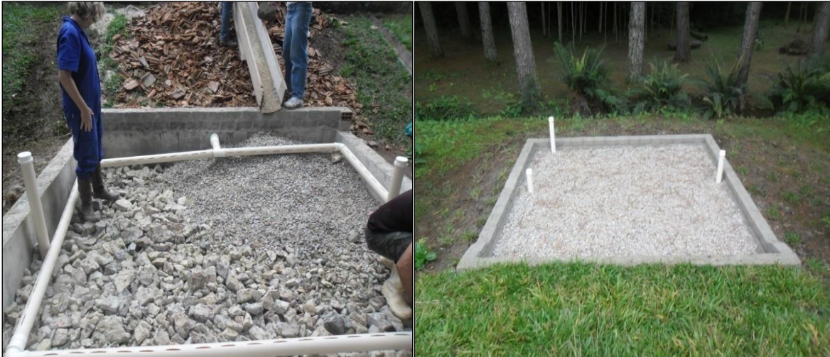
Figura 22 A. Filtro sendo finalizado. 22 B. Estação pronta. Fonte: Autora.
