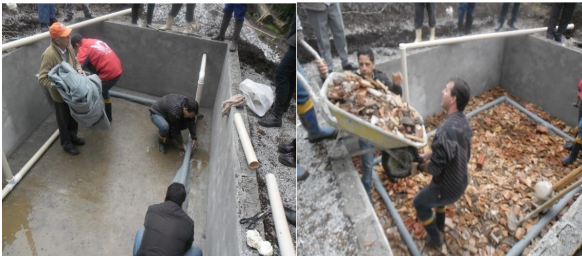
Figura 13 A. Colocação da Manta. B. Preenchimento com telhas.
