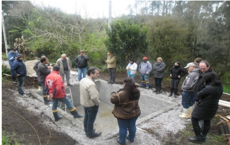
Figura 11. Tanque de raízes, pronto para receber os materiais filtrantes.
