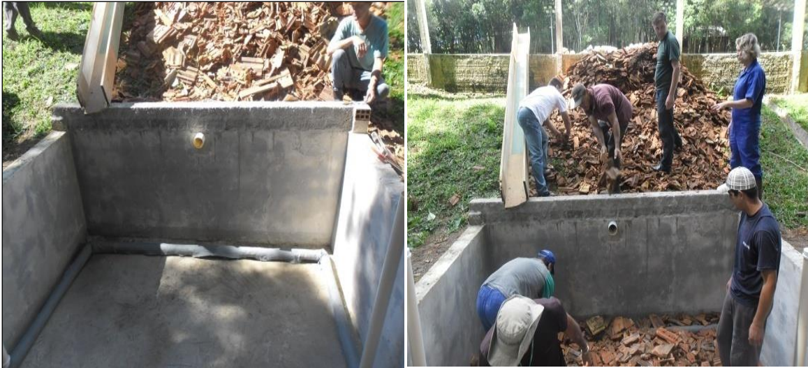
Figura 21 A. Colocação da Manta. B. Preenchimento com telhas. Fonte: Autora.
