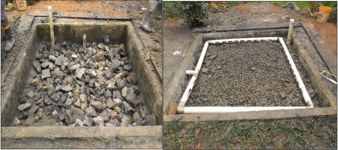
Figura 19 A. Preenchimento do meio suporte. B. ETEZR pronta para receber os efluentes. Fonte: Autora.
