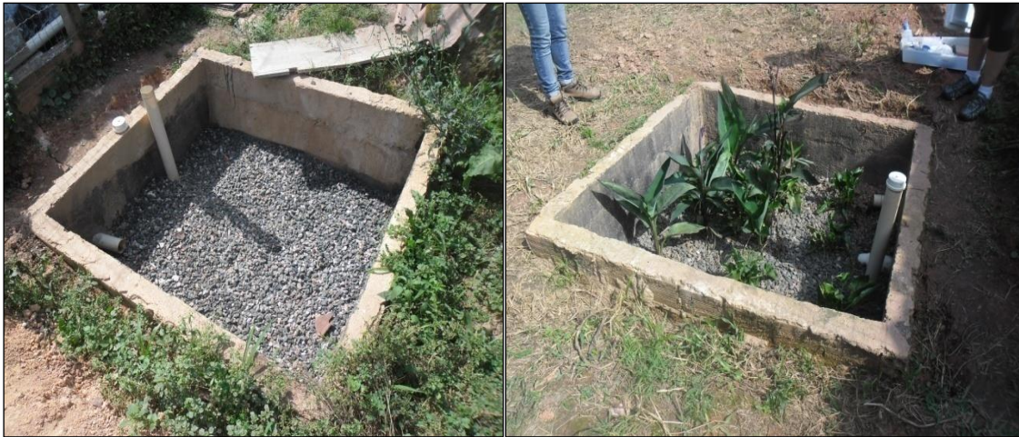
Figura 27- A. ETE finalizada.
