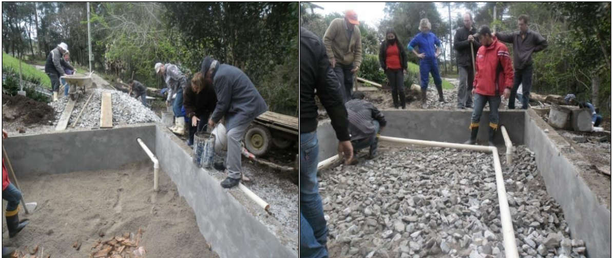
Figura 14 A. Preenchimento com areia. B. Pedras e tubulação. Fonte: Autora.
