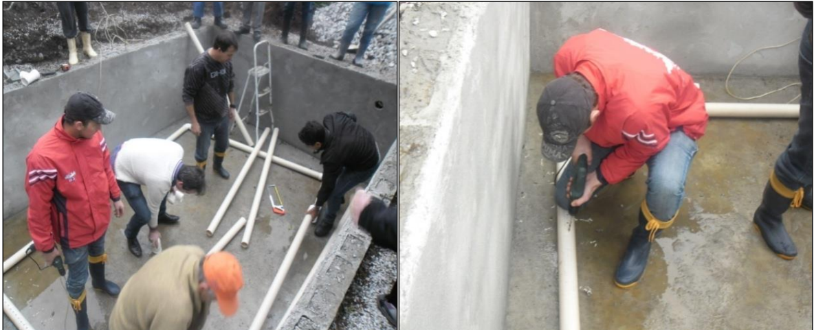
Figura 12 A. Encaixe das tubulações. B. Perfuração para distribuição. Fonte: Autora.
