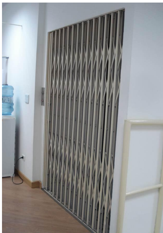
Figura 7 - Fechamento de abertura na parede Fonte: Autora, 2012.
