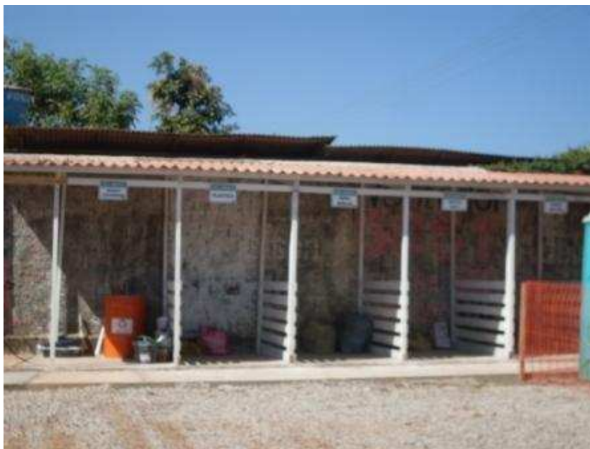
Figura 5 – Central de resíduos na obra da ferrovia em Parauapebas, PA.
