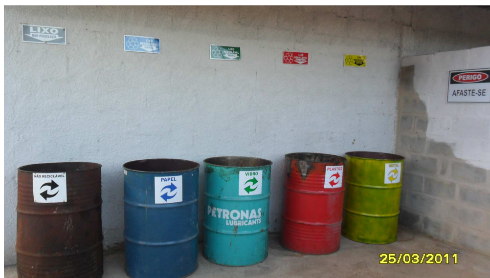
Figura 2 - Central de resíduos da obra da rodovia em Fundão, ES. Detalhe dos tambores de coleta seletiva.
