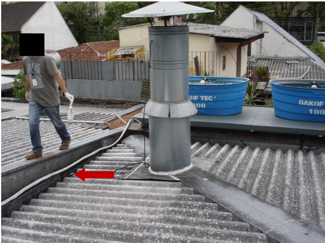
Figura 7 – Rampa de acesso ao local de instalação dos biorreatores.
