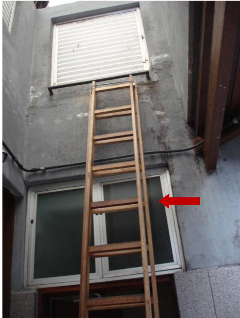
Figura 4 – Escada de acesso ao sistema, levantamento e retirada de cargas.
