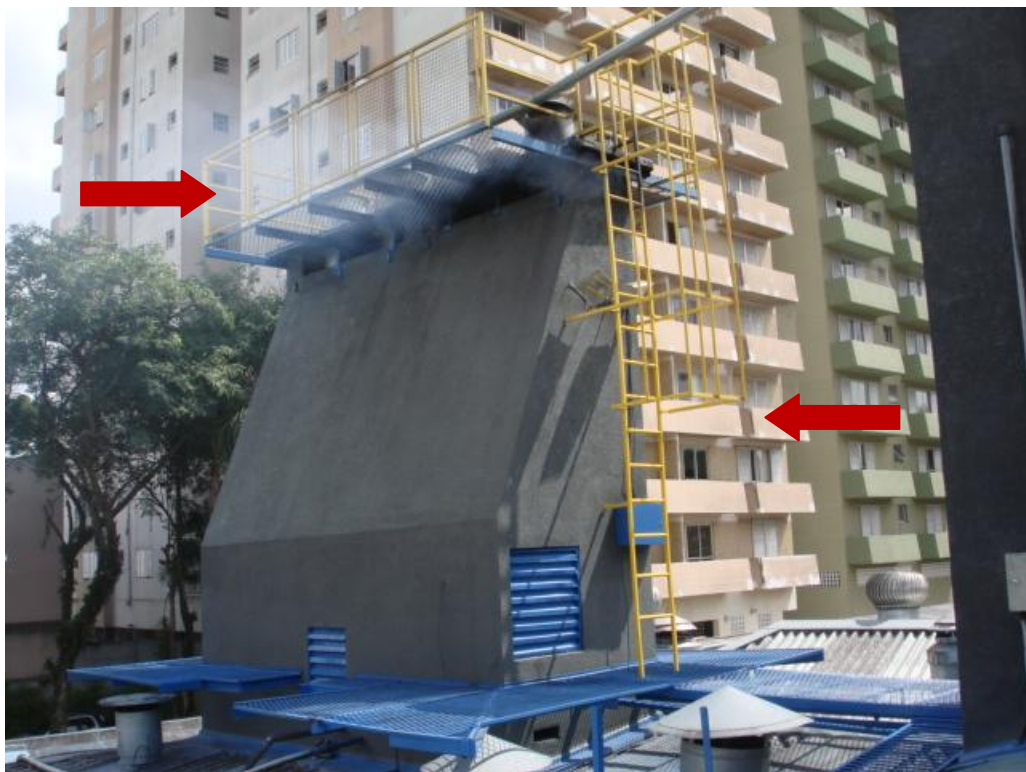
Figura 10 – Escada com proteção e chaminé com guarda corpo.
