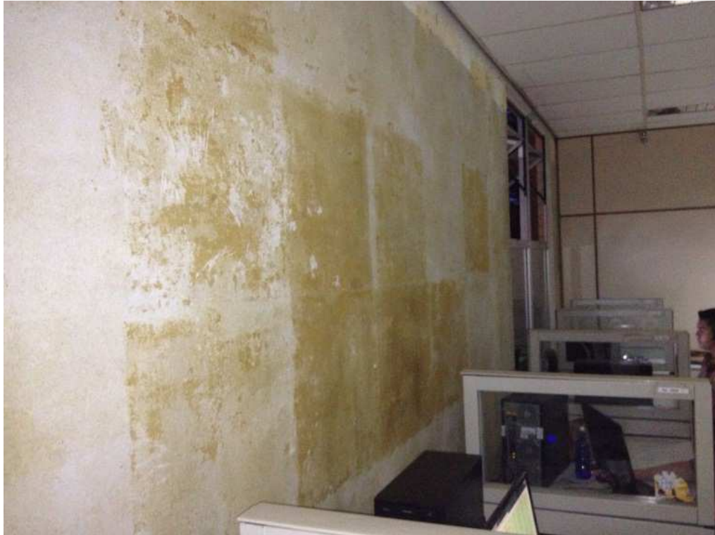
Figura 09: Falta de Proteção Acústica Fonte: autor, 2012.
