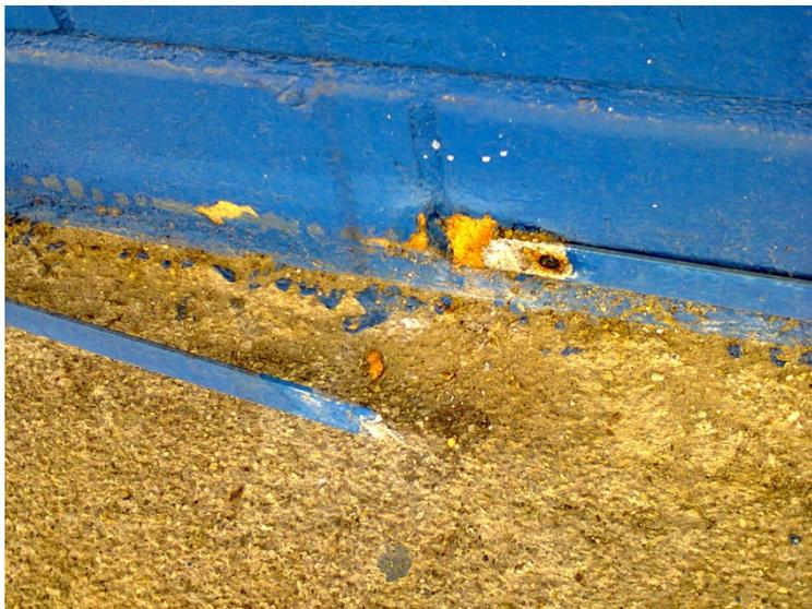
Figura 09: Fita de alumínio de interligação dos eletrodos rompida.
