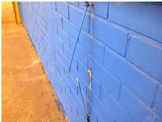
Figura 07: Fita de alumínio de descida rompida.
