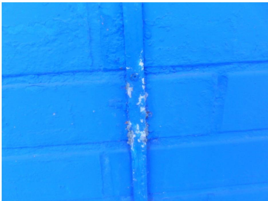
Figura 06: Fita de alumínio de descida com sinais de corrosão.
