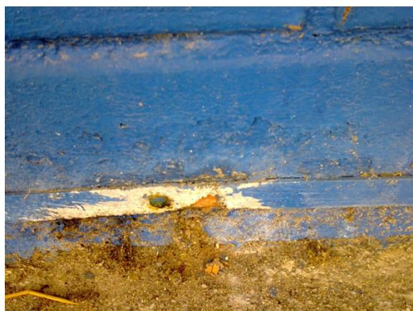
Figura 08: Fita de alumínio de interligação dos captadores com sinais de corrosão.
