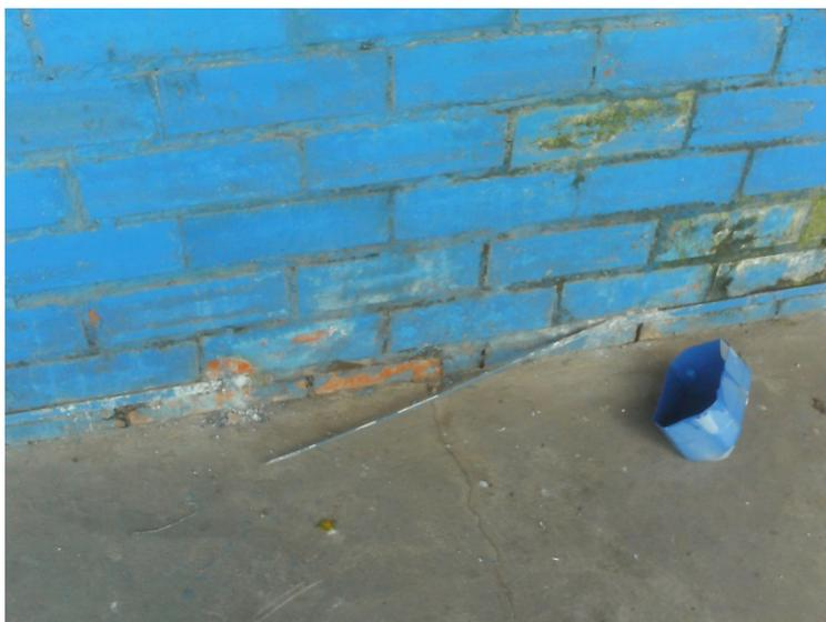
Figura 10: Fita de alumínio de interligação dos eletrodos rompida.
