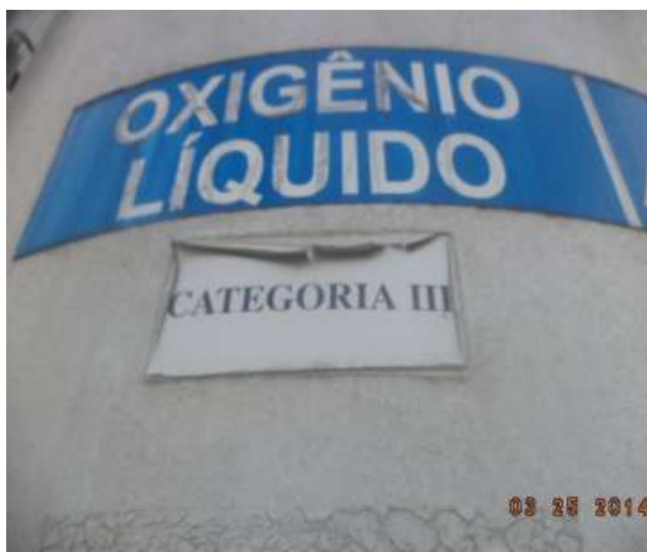
Figura 29 - Etiqueta contendo a informação da categoria do vaso de pressão e seu número ou código de identificação Fonte: Autor (2014).
