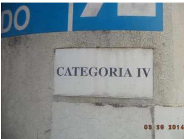
Figura 22 – Etiqueta contendo a informação da categoria do vaso de pressão Fonte: Autor (2014).
