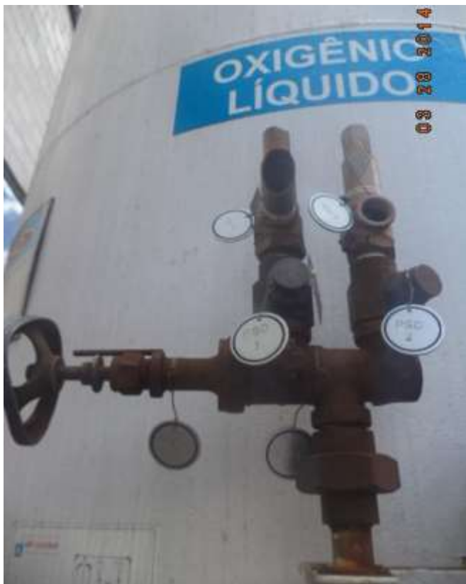
Figura 15 – Válvulas de pressão
