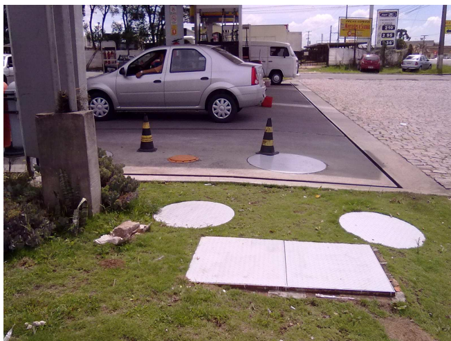
Figura 8 – Vista geral da CSAO-02 do empreendimento. Fonte: Autor (2014).
