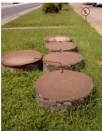
Figura 7 – Vista geral da CSAO-01 do empreendimento. Fonte: Autor (2014)
