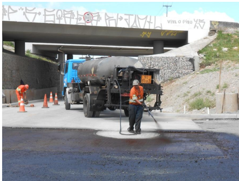
Figura 01: Pintura de Ligação
