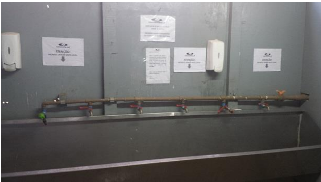
Figura 2 – Vista dos lavatórios do empreendimento A Fonte: O autor (2015).
