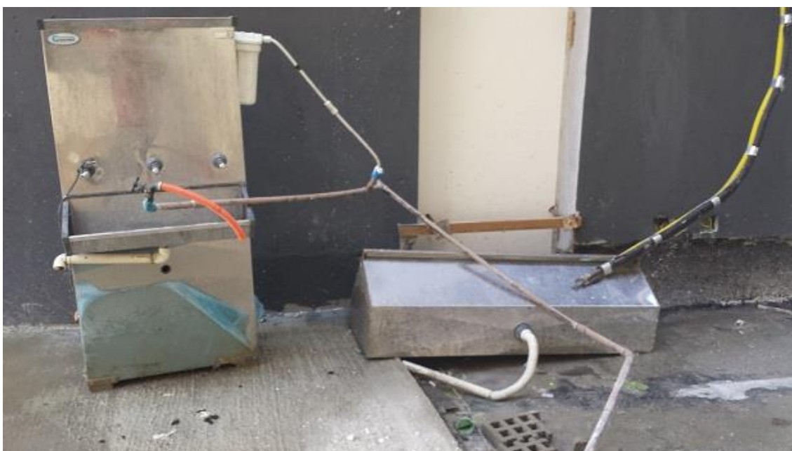
Figura 7 – Vista do bebedouro do empreendimento B Fonte: O autor (2015).
