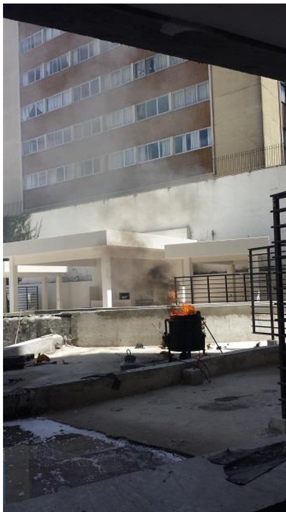
Figura 9 – Vista do serviço de impermeabilização do empreendimento B Fonte: O autor (2015).
