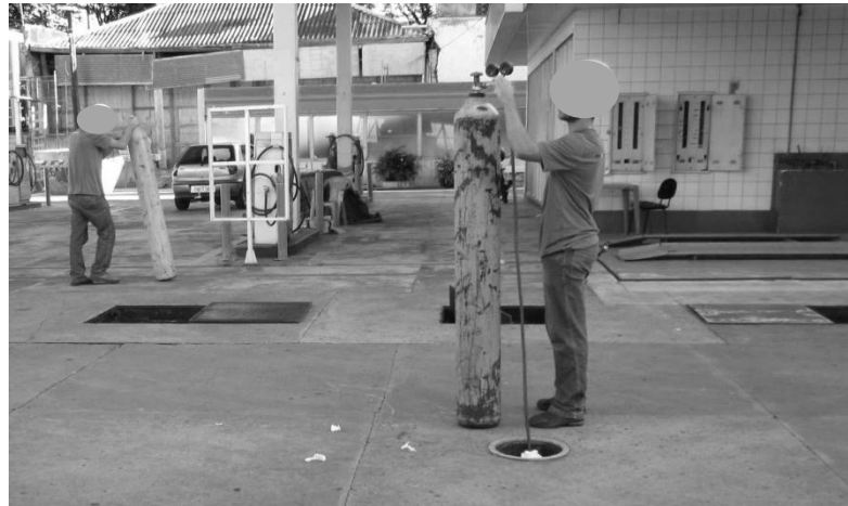
Figura 6 – Inertização dos tanques. Fonte: Geoparaná Consultoria Ltda., 2016
