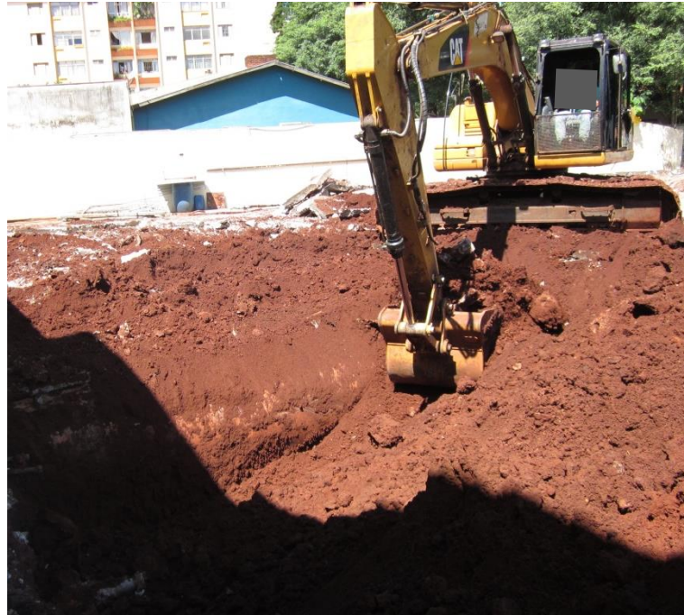
Figura 8 – Escavação do solo. Fonte: A autora, 2015
