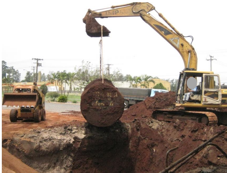
Figura 12 – Tanque içado com a escavadeira. Fonte: a autora, 2016.
