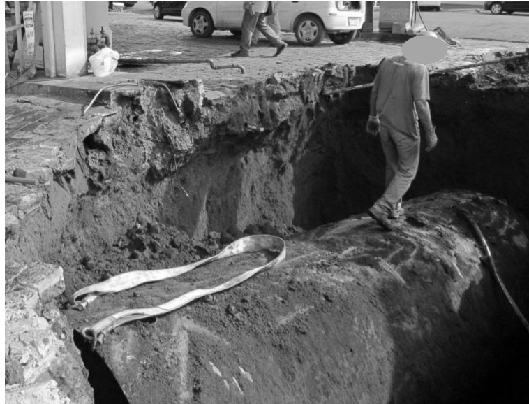
Figura 15 – Profissional sobre o tanque sem o equipamento necessário. Fonte: a autora, 2013
