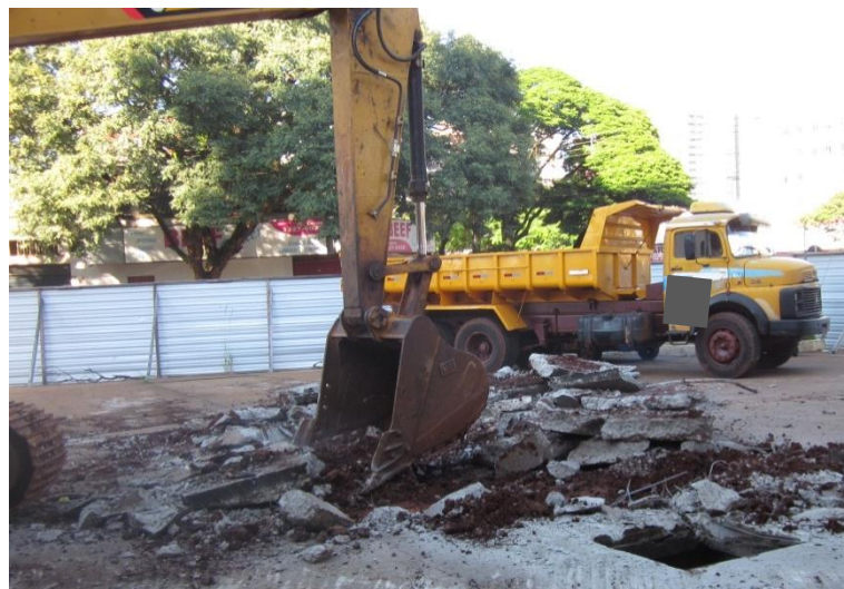
Figura 7 – Escavação para remoção do concreto.
