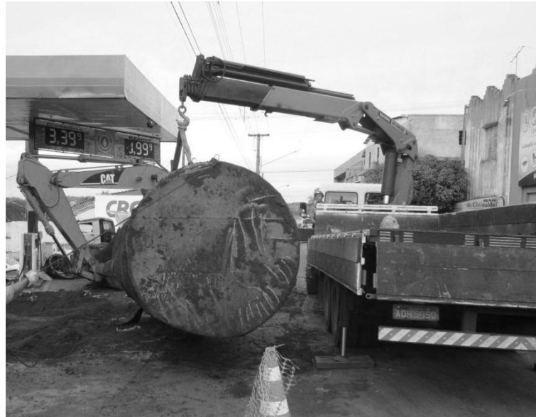
Figura 9 – Içamento do tanque. Fonte: Geoparaná Consultoria Ltda., 2015
