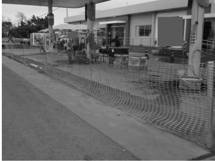
Figura 3 – Isolamento da área. Fonte: Geoparaná Consultoria Ltda., 2016
