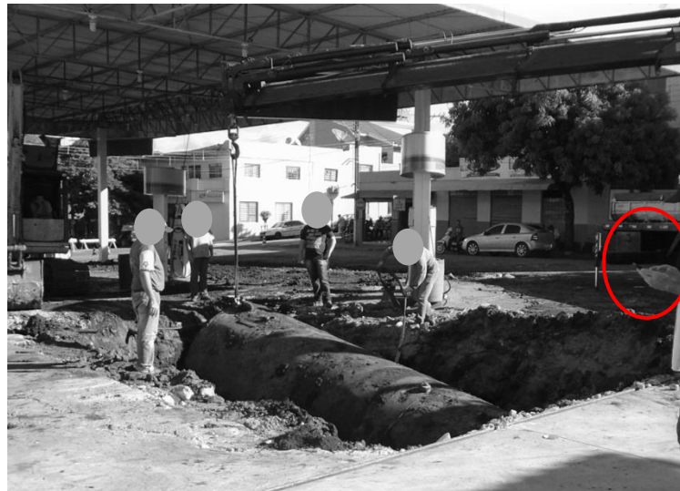
Figura 14 – Remoção de tanques sem o isolamento da área. Fonte: a autora, 2016
