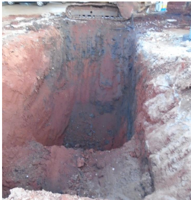
Figura 11 – Profundidade da cava após a remoção de solo contaminado. Fonte: a autora, 2017
