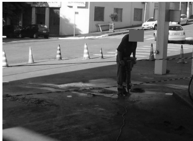
Figura 5 – Quebra do piso com auxílio de martelete.
