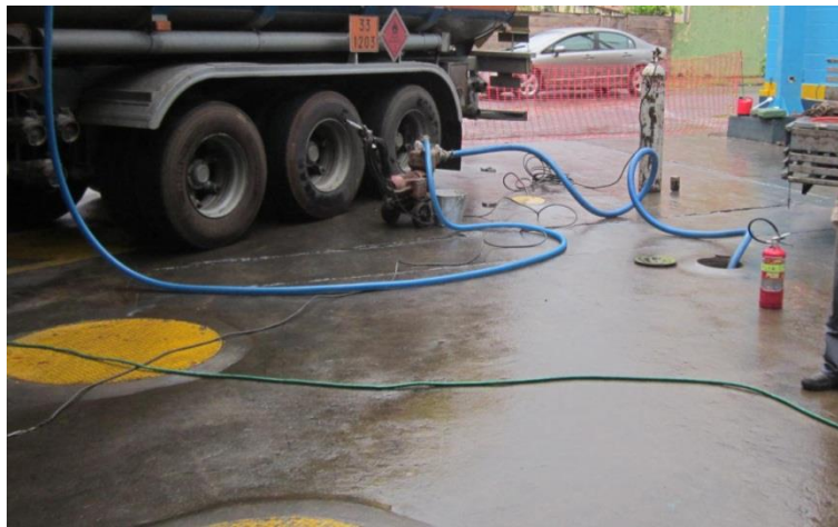
Figura 4 – Remoção do lastro. Fonte: Geoparaná Consultoria Ltda., 2016
