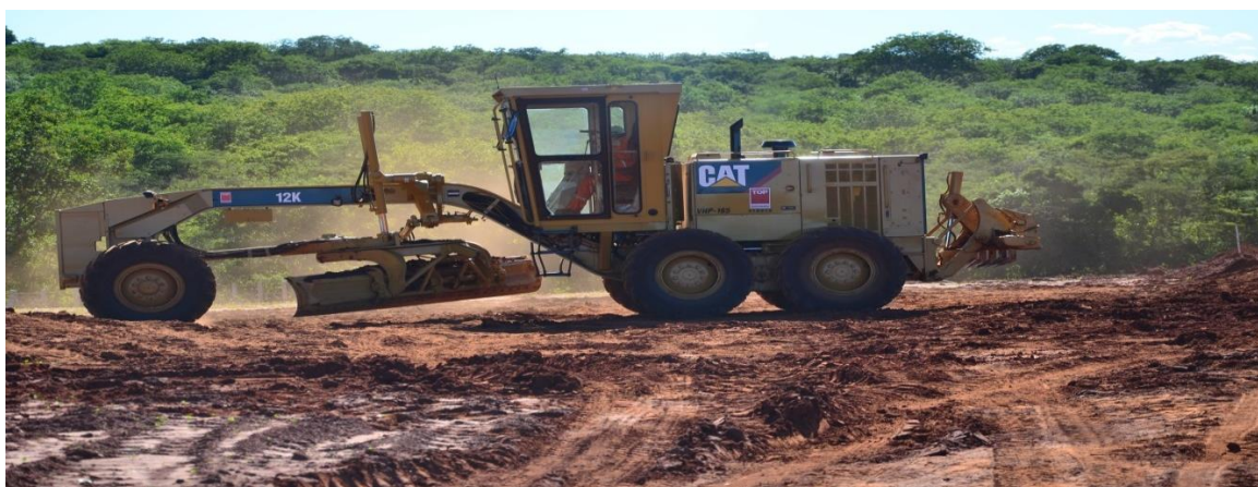
Figura 6 - Atividade de nivelamento na rodovia no lote 1 Fonte: ITTI/UFPR
