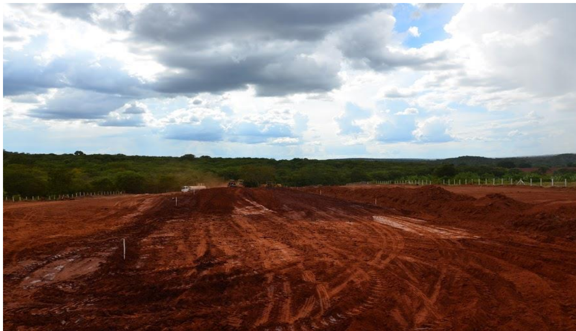
Figura 11 - Terraplanagem nas obras do lote 2 Fonte: ITTI/UFPR (2017)
