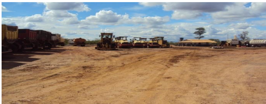
Figura 13 - Máquinas utilizadas nas obras do lote 2 Fonte: ITTI/UFPR (2016)
