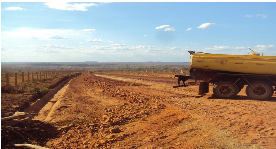
Figura 7 - Terraplanagem no lote 2. Fonte: UFPR/ITTI
