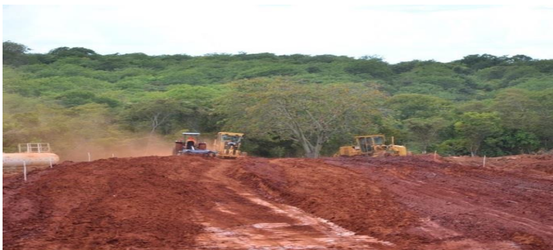
Figura 8 - Visão geral das obras no lote 1, em março de 2017 Fonte: UFPR/ITTI
