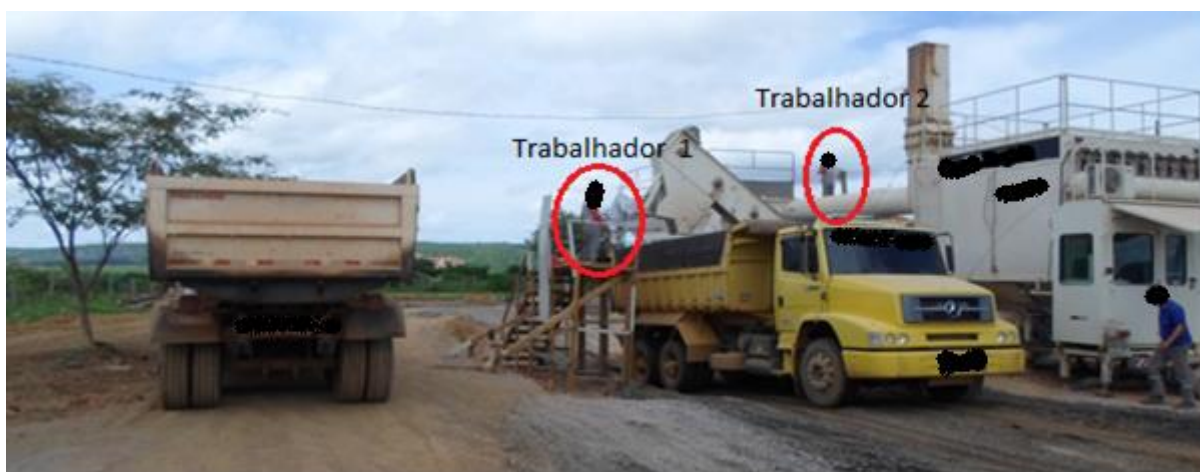
Figura 15 – Usina de asfalto, com os postos de trabalho a serem estudados. Fonte: UFPR/ITTI
