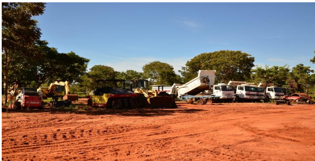
Figura 9 - Canteiro de obras Fonte: UFPR/ITTI
