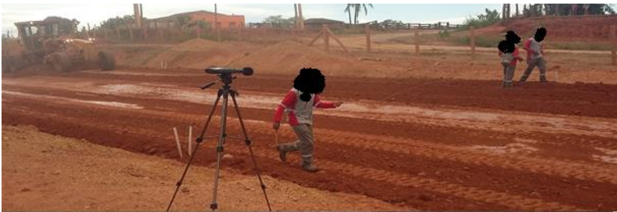
Figura 16- Auxiliares de terraplanagem na frente de obra do lote 2 Fonte: UFPR/ITTI
