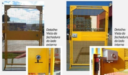
Cancela do pavimento com fechadura de segurança mecânica com bloqueio de abertura com chave
