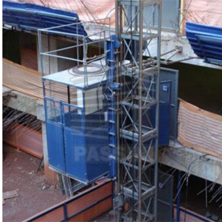
FIGURA 1: Obra usando elevador cremalheira
