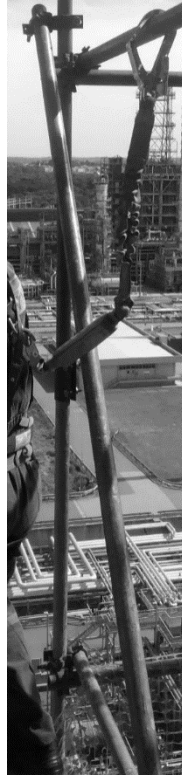
FIGURA 5: Uso do cinto de segurança tipo paraquedista com absorvedor de energia e talabarte duplo
