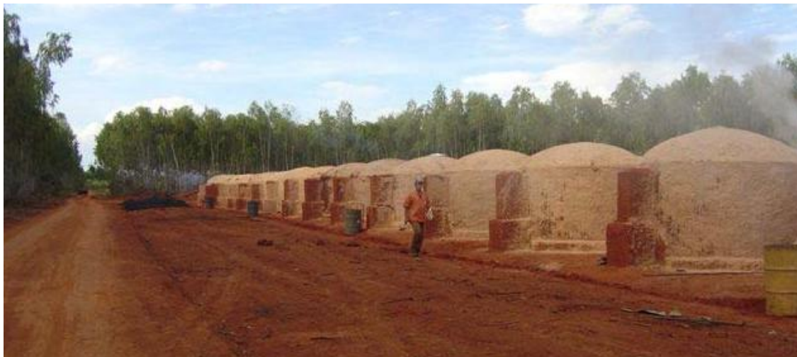
Figura 3. Vista geral de uma carvoaria com fornos do tipo rabo quente. FONTE: Pinheiro et al. (2006).
