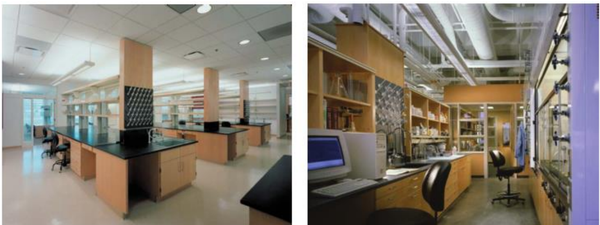
Figura 3 – Sistemas de iluminação direta e indireta em laboratórios. Fonte: KOZMINSKI et al. (2006)
