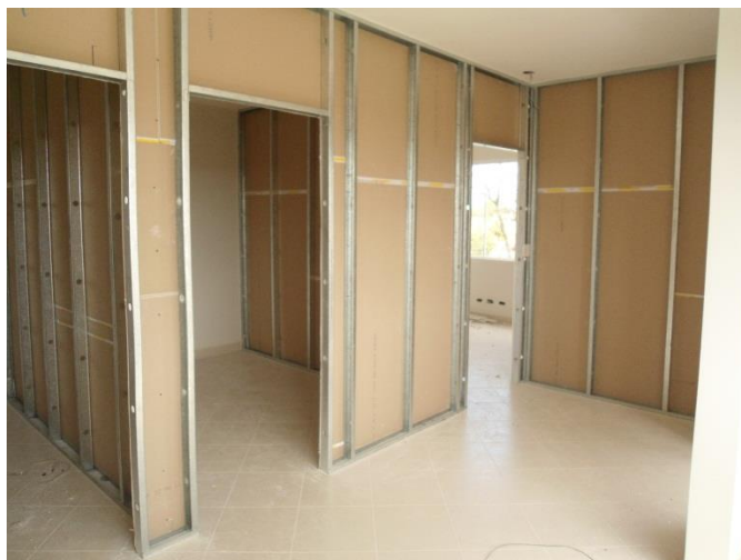
Figura 3. Instalação de Chapas para Drywall (obra 05) - Fonte: Autor
