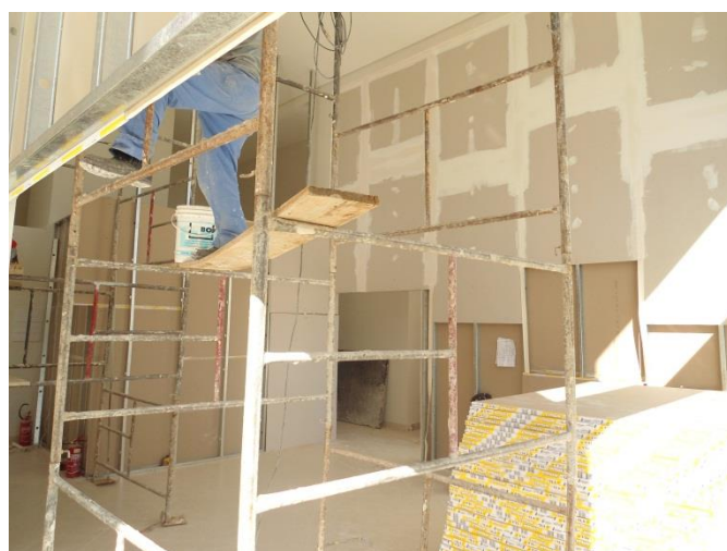
Figura 4. Instalação de Chapas para Drywall (obra 05) – Fonte: Autor
