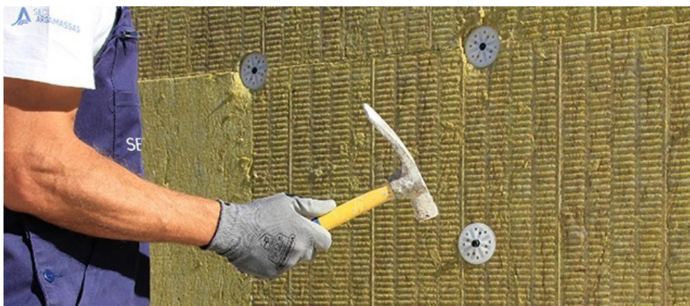
Figura 35 – Placas de lã de rocha com recurso a fixação mecânica. (SECIL ARGAMASSAS, 2014)
