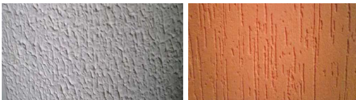
Figura 31 – Exemplo de revestimentos texturizado com tinta de areia (esquerda) e com estrias verticais, tipo graffiato (direita). (SILVA, 2013)
