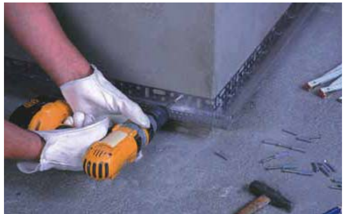
Figura 20 - Detalhes do sistema de fixação: (à esquerda) corte esquemático demonstrando o arremate na base do sistema (LENA, 2010) e (à direita) colocação do perfil metálico utilizado como suporte na base do ETICS (MAPEI, 2014)
