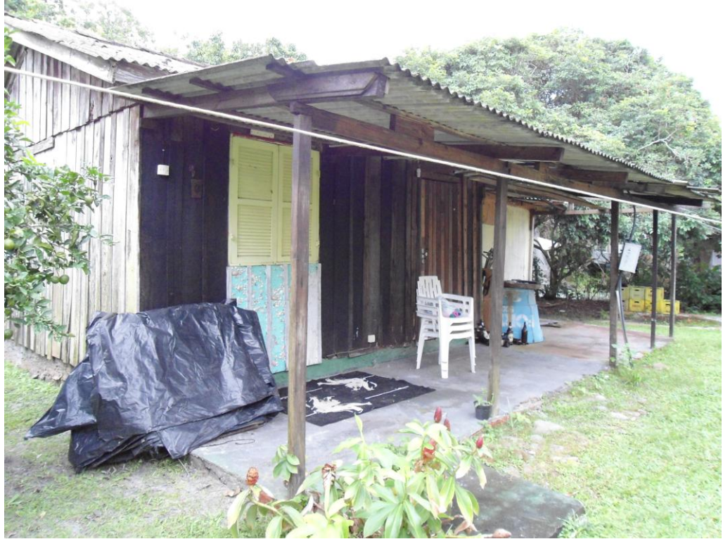
Figura 10 – Casa dos fundos
