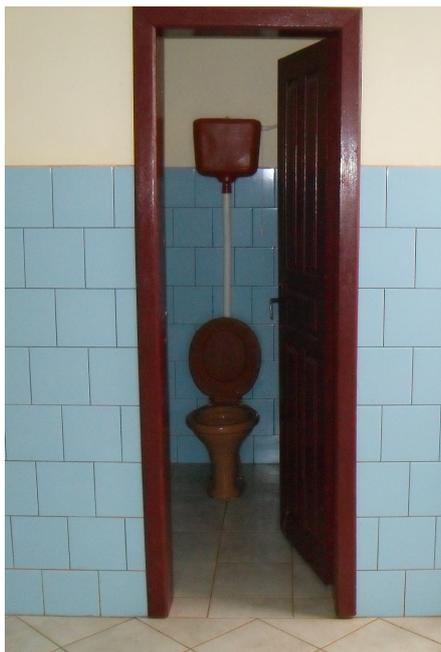
**Figura 6: Bacia sanitária com caixa elevada do banheiro masculino do pavimento superior do clube**
