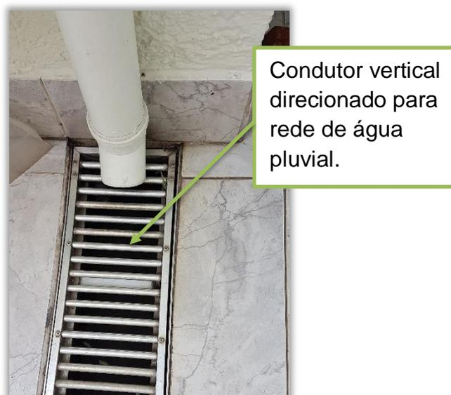
Figura 26 – Rede de água pluvial.
