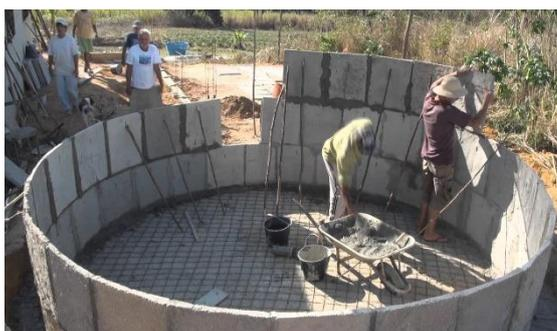
Figura 18 – Cisterna Concreto Armado
