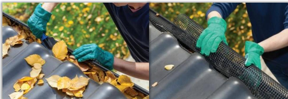
Figura 13 – Proteção de Calhas
