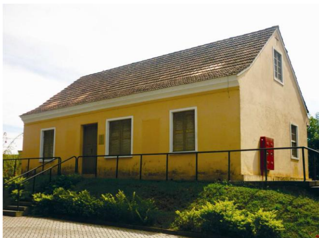
Figura 11: Foto da Casa dos Contos (Caso III). Fonte: TESSARI (2014).
