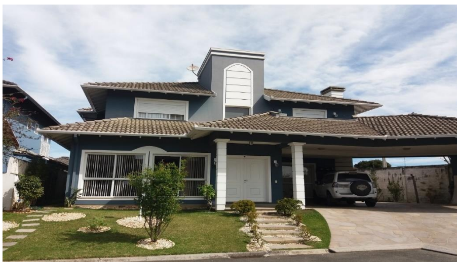
Figura 12: Foto Residência 01 localizada no Condomínio A. Fonte: autora (2016).
