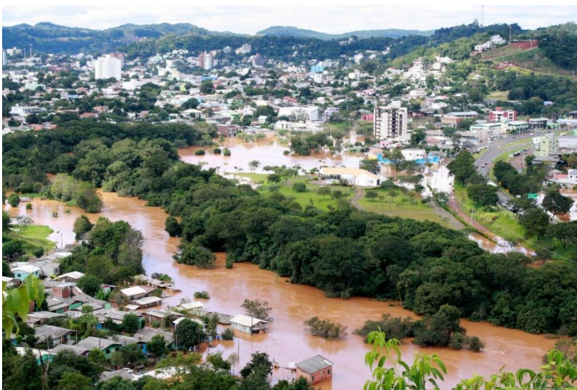
Figura 11 – Situação da Cidade na Ocorrência de Uma Inundação
