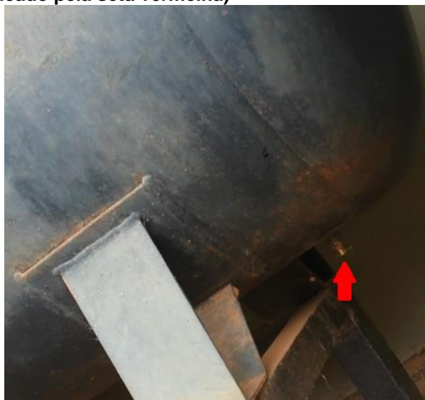
Figura 4: Purgador (indicado pela seta vermelha)
