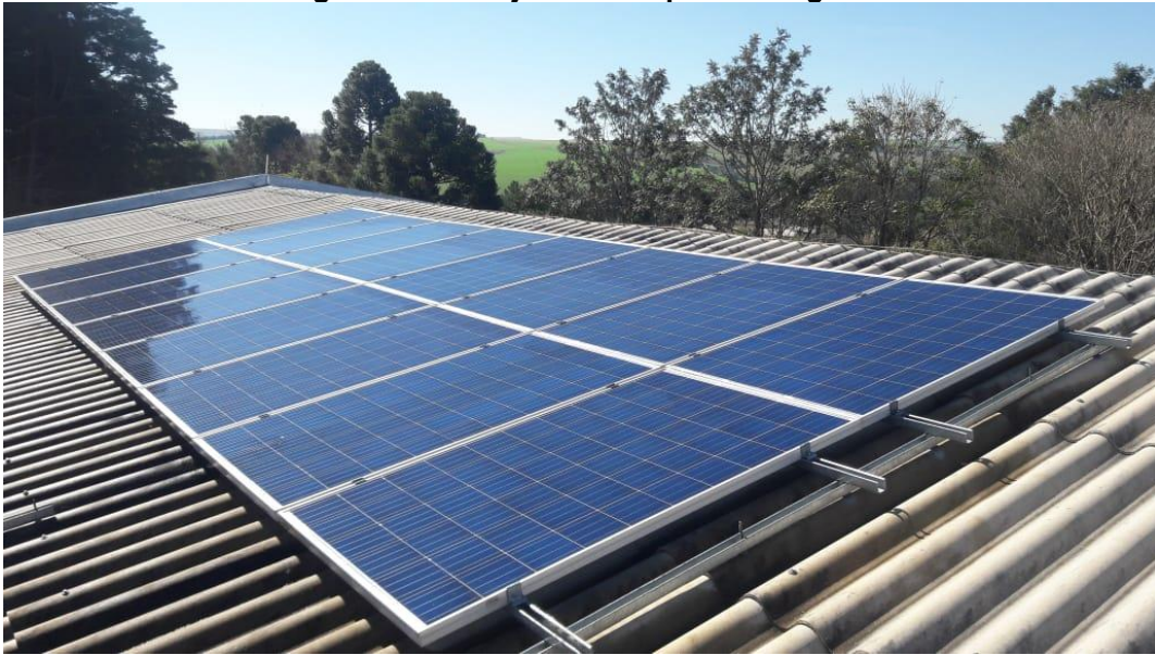
Figura 20: Arranjo UTFPR após a lavagem.
