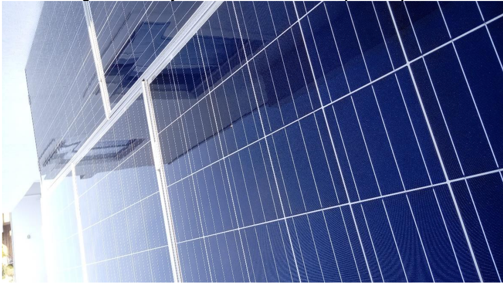
Figura 23: Arranjo da casa em condomínio após a limpeza.
