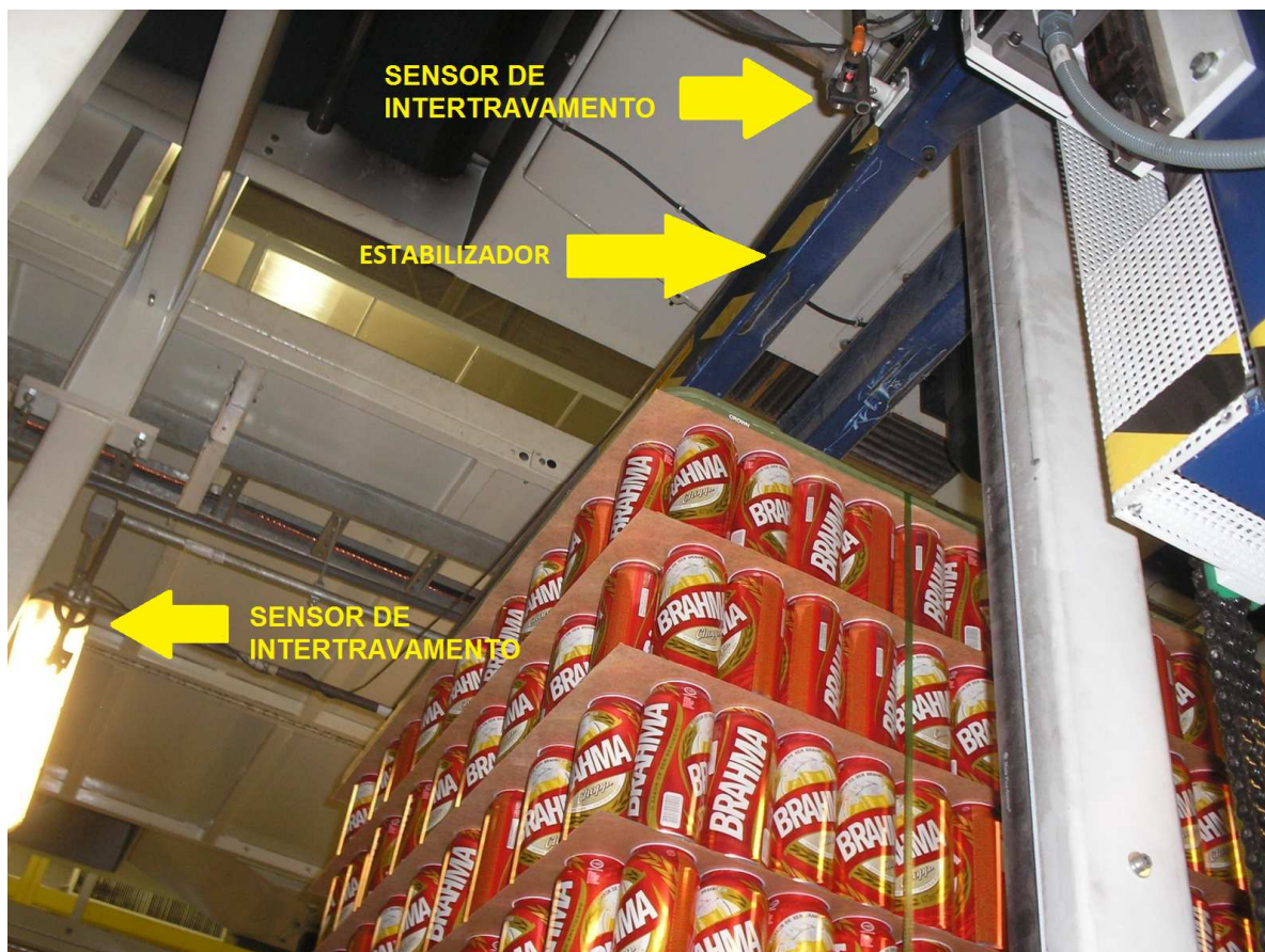
Fotografia 8 - Estabilizador onde foi instalado o sensor de intertravamento. Fonte: Autoria Própria
