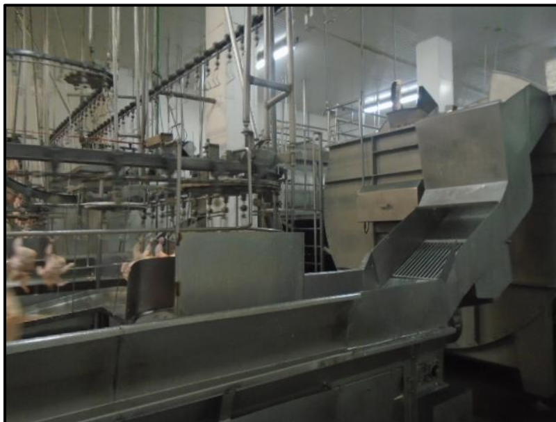
Figura 2 – Saída do chiller de pré-resfriamento das aves na linha de abate Fonte: Autoria própria.
