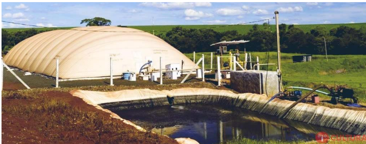
Figura 5 - Modelo de biodigestor canadense com lagoa de estabilização Fonte: http://www.radioculturafoz.com.br (2017)
