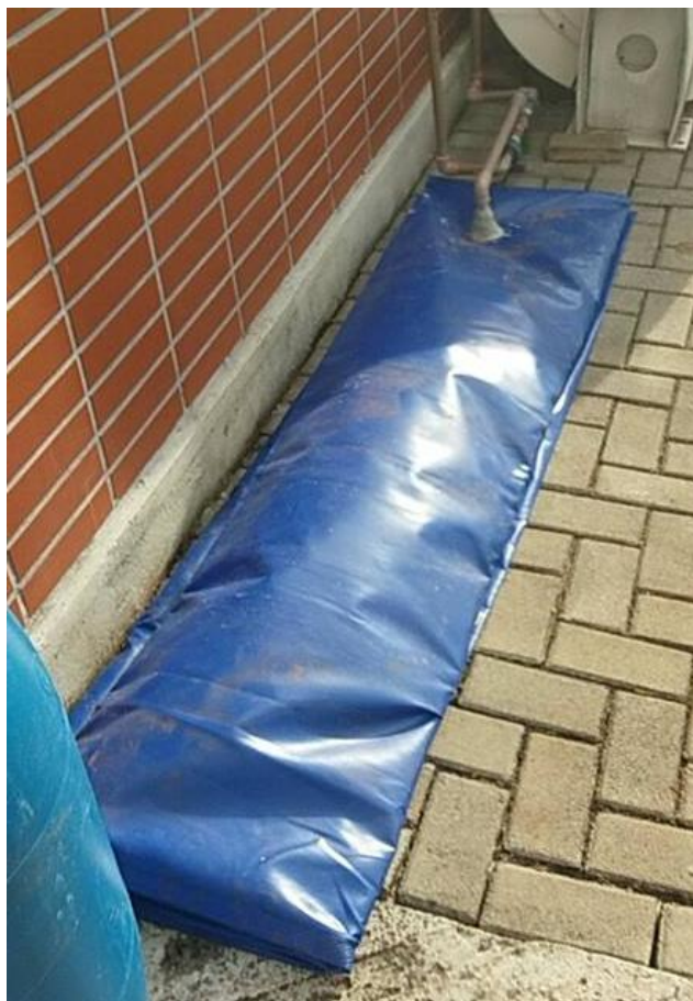
Figura 17 - Gasômetro utilizado para o armazenamento do biogás produzido Fonte: Autoria própria (2017)
