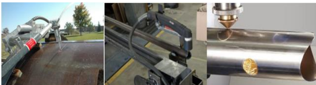
Figura 17- Fabricação de bocas de lobo utilizando máquinas CNC com corte térmico
