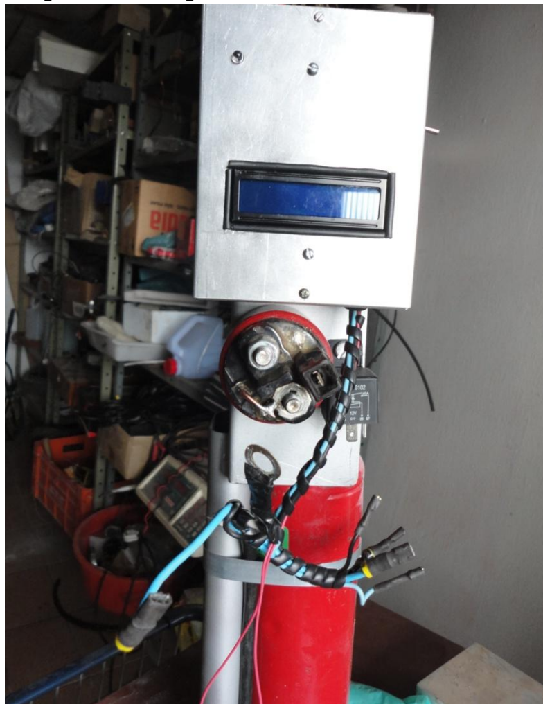
Fotografia 35: Montagem do Módulo de Controle.
