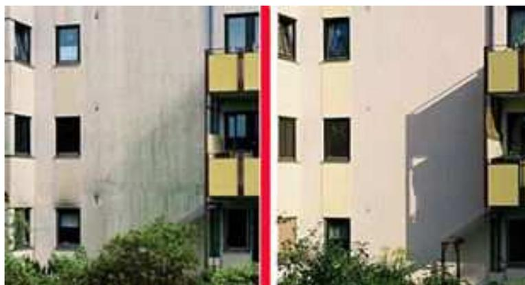
**Figura 19 - Comparação de um prédio sem a Lotusan aplicada (esquerda) e com a Lotusan (direita)**
